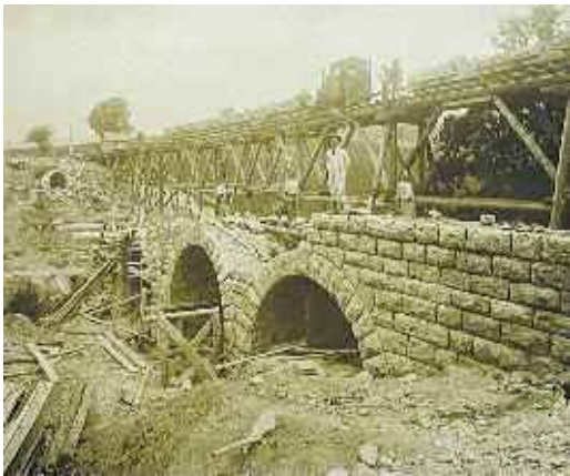
Bau eines Aquäduktes an der II. Hochquellenleitung
